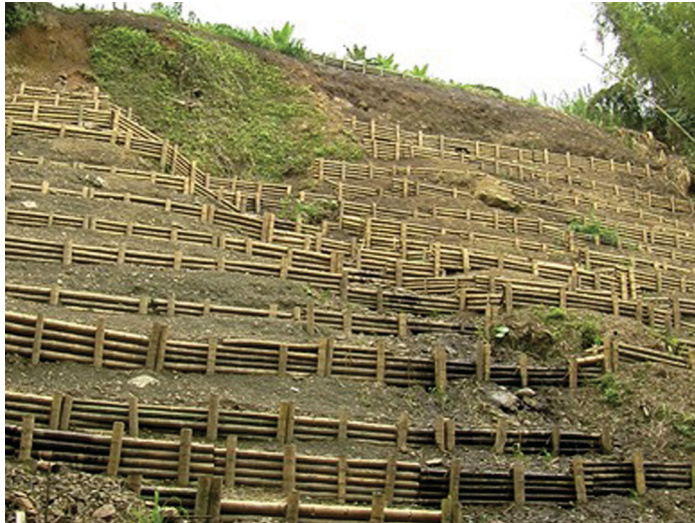
Restauración de tierras degradadas, con trinchos y reforestación
